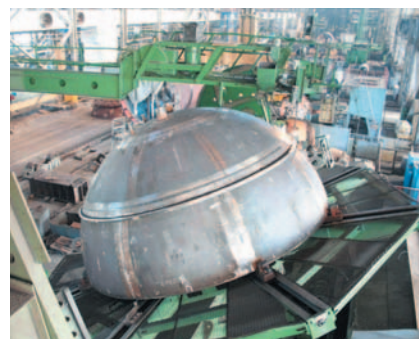
Сварка полушарового днища
