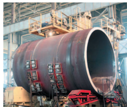
Сварка обечайки реактора
